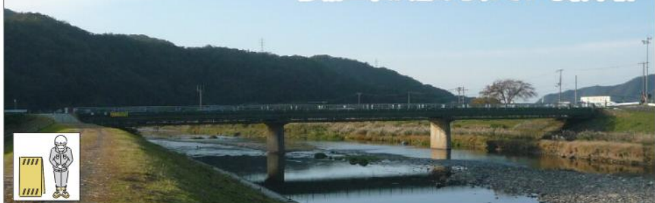
修繕工事が進められている新市橋
